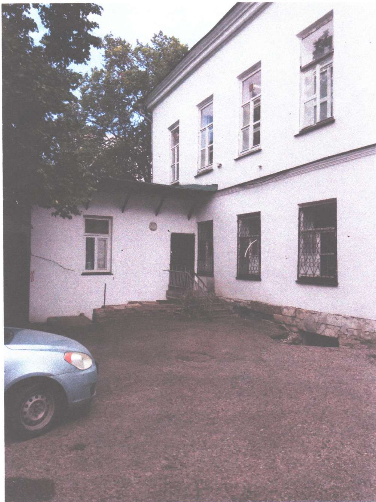
Фото места разгрузки у здания Гимназия 1_Спасская 18
